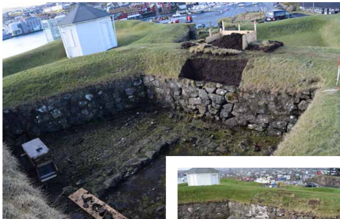
Umvælingin er byrjað og flagið tikið av. Tað sæst týðiliga, at múrurin er illa farin og sera glopruttur
